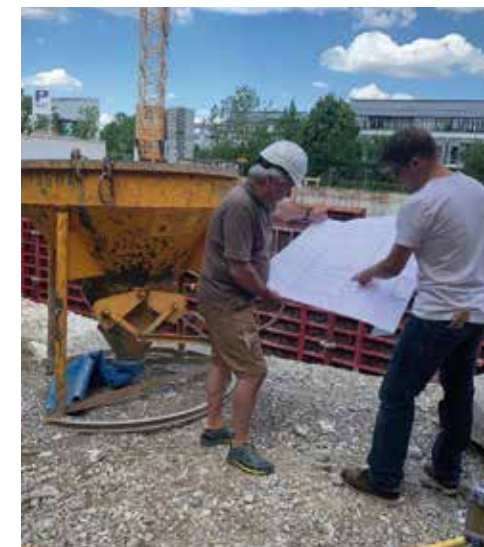
Josef Schweinsteiger (r.), Architekturbüro WSB-Architekten, und Max Wagmann, Baubetreuer AWOohnbau, auf der Baustelle am Floriansanger.
